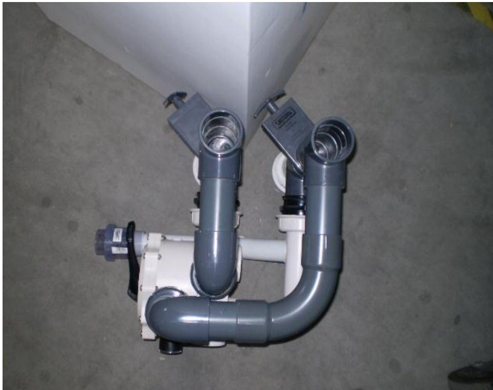
**Montieren Sie dieses Teil, indem Sie zuerst das 6Wegeventil in den Bypass stecken
